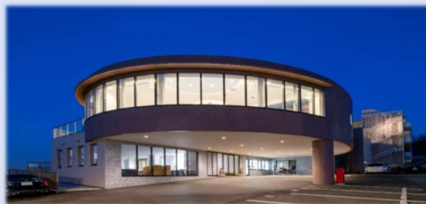
「わかたけ南」施設外観
